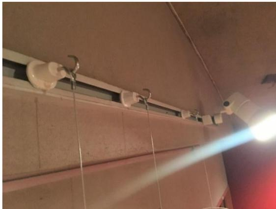
ライティングレールに既製フックを取付け、ワイヤーを引っ掛ける事でハンギングアイテムを吊るす事が出来ます。
