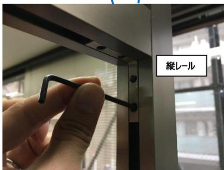
縦レールに固定しているコーナピースを緩めれば、横レールの位置を変えられます。
