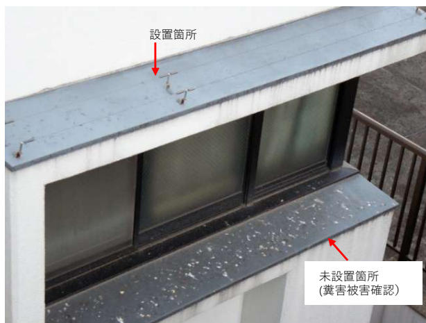
マンション開口底部
