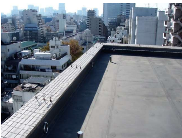
マンション屋上パラベット
