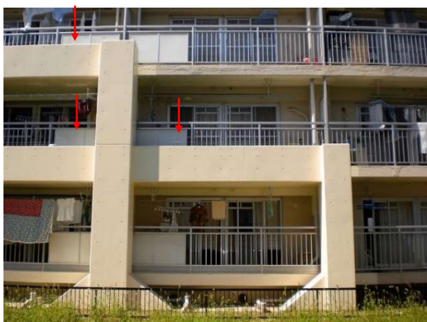
都営住宅 耐震改修工事 (コンクリート打ちタイプ)
