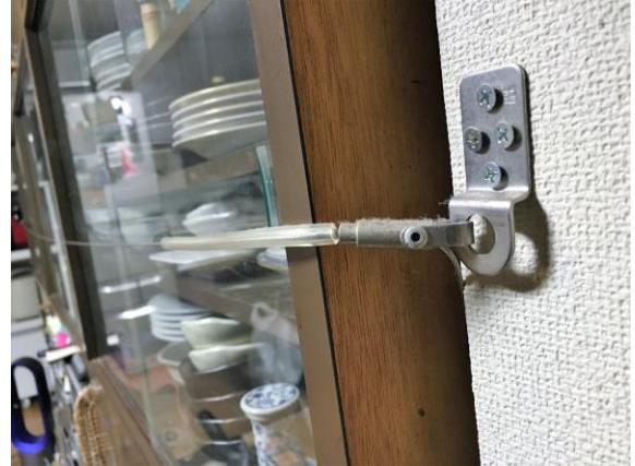
ワイヤー保護チューブを棚との接触部に取付、棚に沿ってワイヤーを設置する
