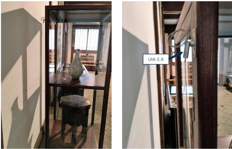
景観的にレールを上端に取り付けたくないとの理由で、視界に入らない下端にレールを取付、
