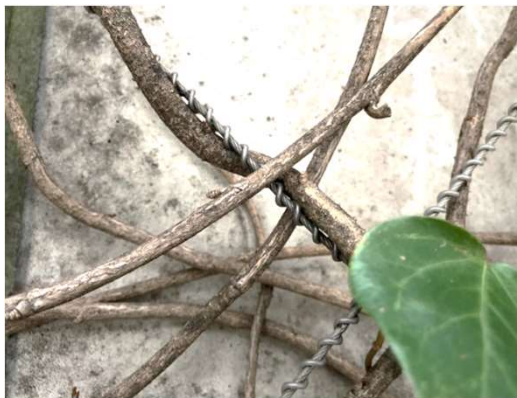
被膜φ6 スパイラルワイヤーセット登攀状況
