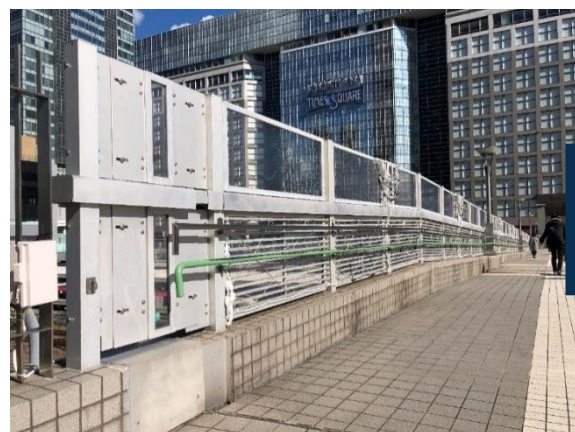
施工前_JR某駅南口ご線橋
