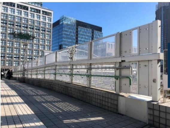
施工前_JR某駅南口こ線橋
