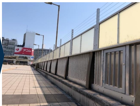
施工後_JR某駅自由通路
