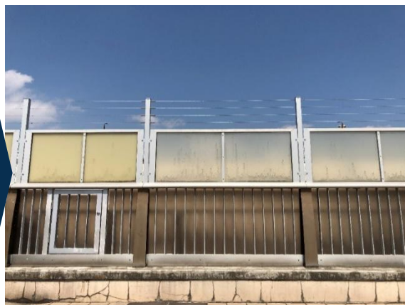
施工後_JR某駅自由通路
