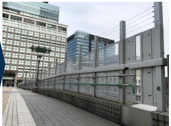
施工後_JR某駅南口こ線橋
