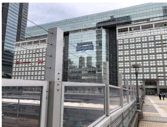
JR某駅南口ご線橋
