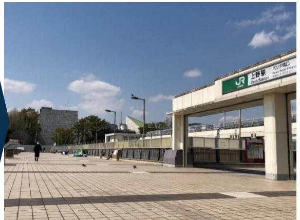
某駅自由通路
