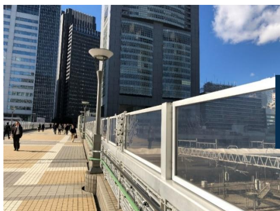
施工前_JR某駅南口ご線橋
