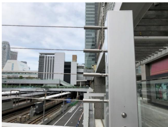
JR某駅南口ご線橋
