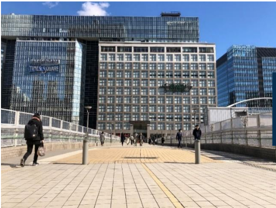
施工前_JR某駅南口こ線橋
