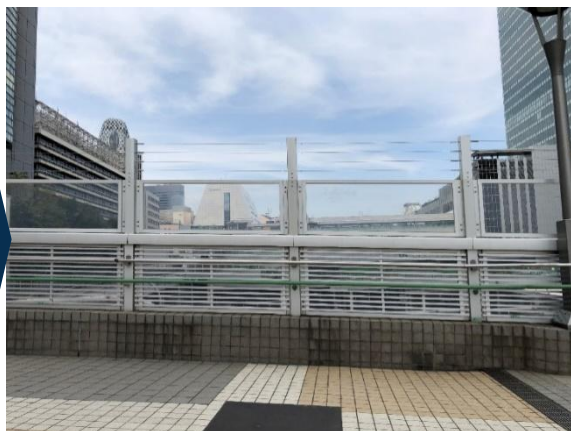
施工後_JR某駅南口ご線橋
