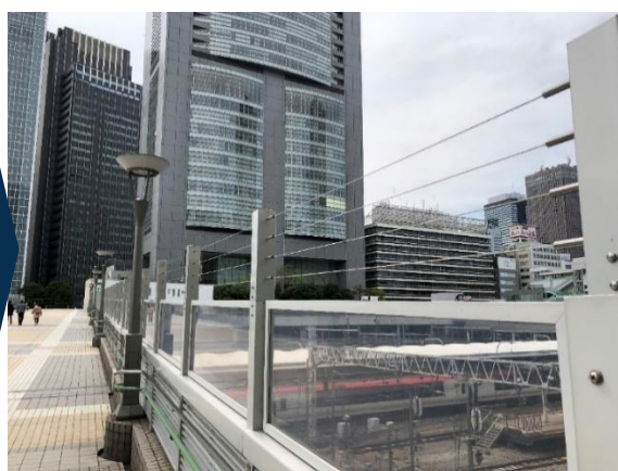
施工後_JR某駅南口ご線橋
