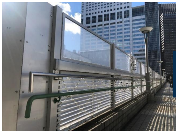
施工前_JR某駅南口ご線橋
